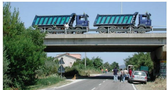
PROVE DI CARICO IN SITO
