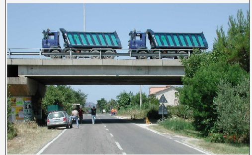
PROVE DI CARICO IN SITO
