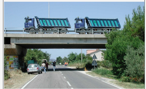
PROVE DI CARICO IN SITO
